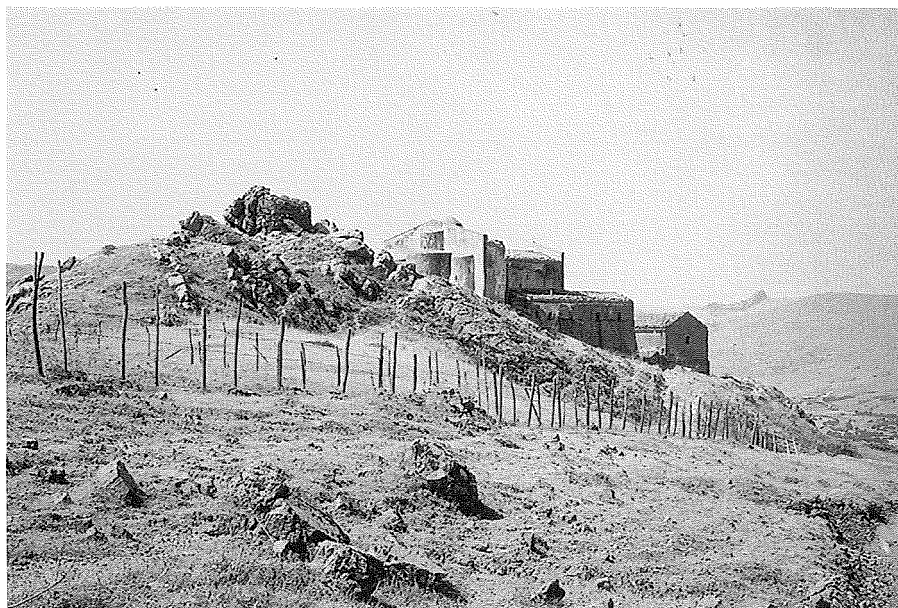
Fig. 2 - La cresta di Spanò da nordest, foto F. Filangeri.
