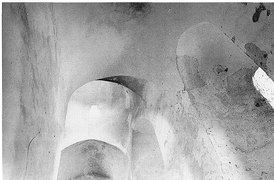
Fig. 9 - Spanò, chiesa, volte e curve del presbiterio, foto F. Filangeri.
