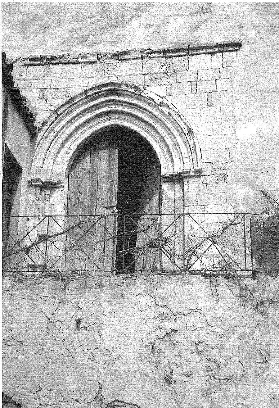
Fig. 13 - Spanò, chiesa, il portale occidentale, foto F. Filangeri.
