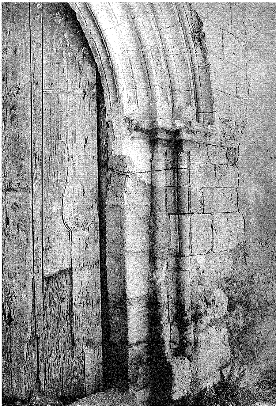
Fig. 14 - Spanò, chiesa, portale occidentale, particolare, foto F. Filangeri.
